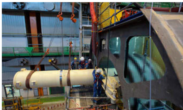
Le programme de construction des sous-marins Barracuda pour la France reste l'une des principales sources de revenus de DCNS.
